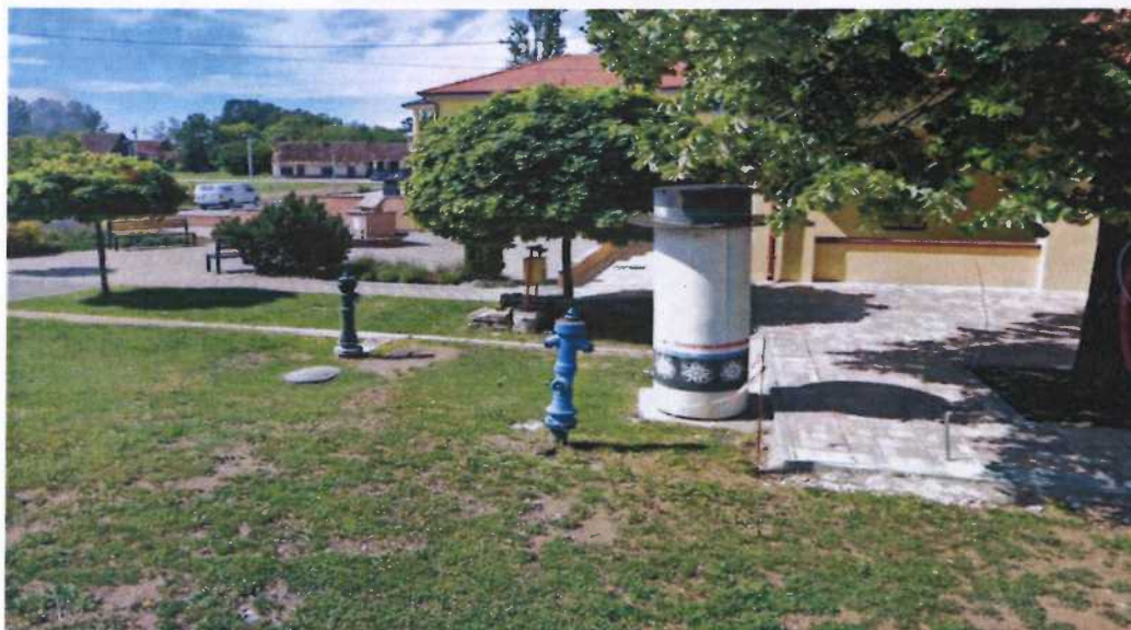
SLIKA 5: NADZEMNI HIDRANT U CENTRU SIKIREVACA
