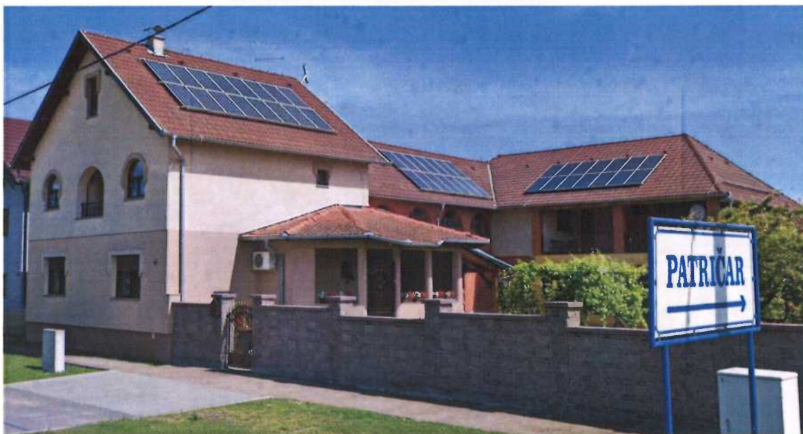
SLIKA 3: SOLARNA ELEKTRANA NA PRIVATNOM OBJEKTU
